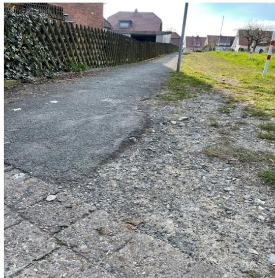
Wege, Fußwege und Übergänge sind oft ausgewaschen von den Witterungen, Pflastersteine und Gehwegplatten sind ausgetreten und stehen teilweise V-förmig zueinander und sind abgesackt. Das macht ein selbstständiges Gehen zur Stolpergefahr und ist somit nur mit Begleitung möglich.
